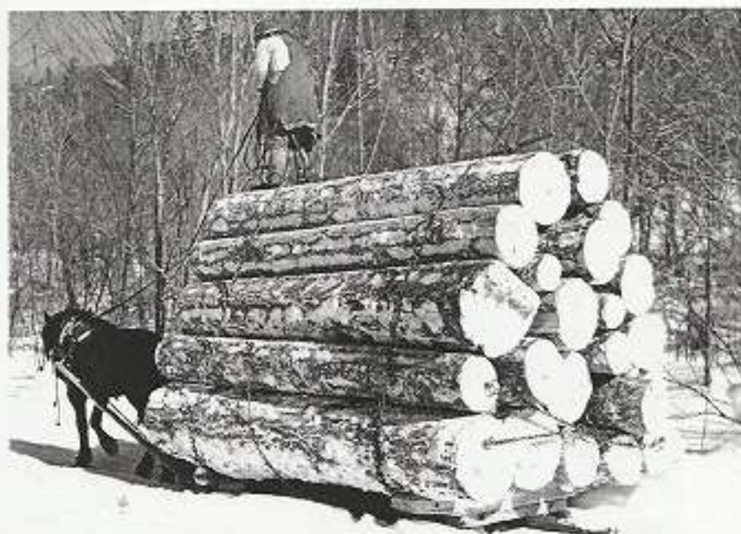
大量運搬に耐え得るよう馬搬出道は敷水し凍らせ補強する
