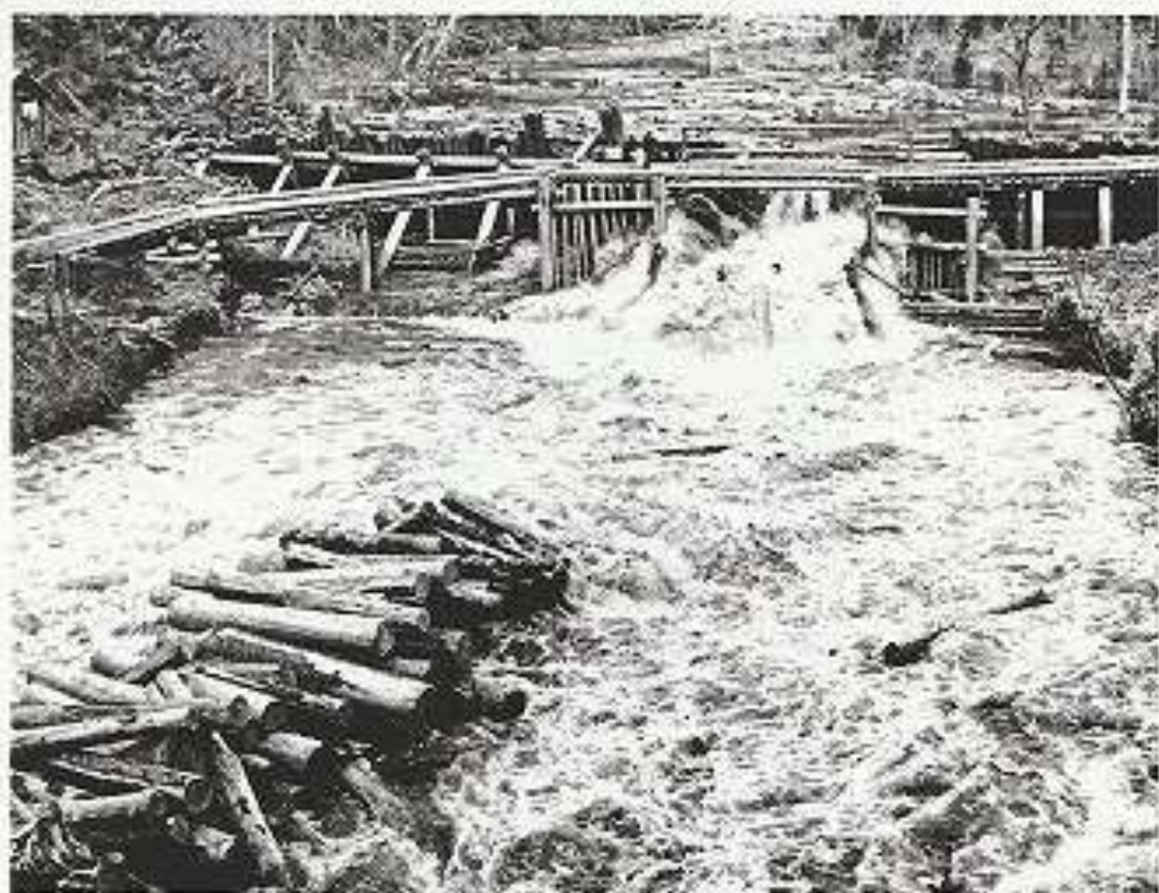
開放5秒後の光景。丸太を飲み込んで一気に蒸下する これぞまさしく、ザ・流送
