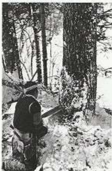
伐根は低く、又、伐倒後の 仕事の都合をよく考えて… 仙夫の腕の見せどころ でもある
