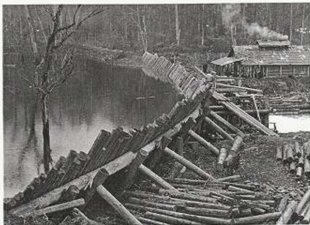
上流堰から流下材を一時受止める受堤
