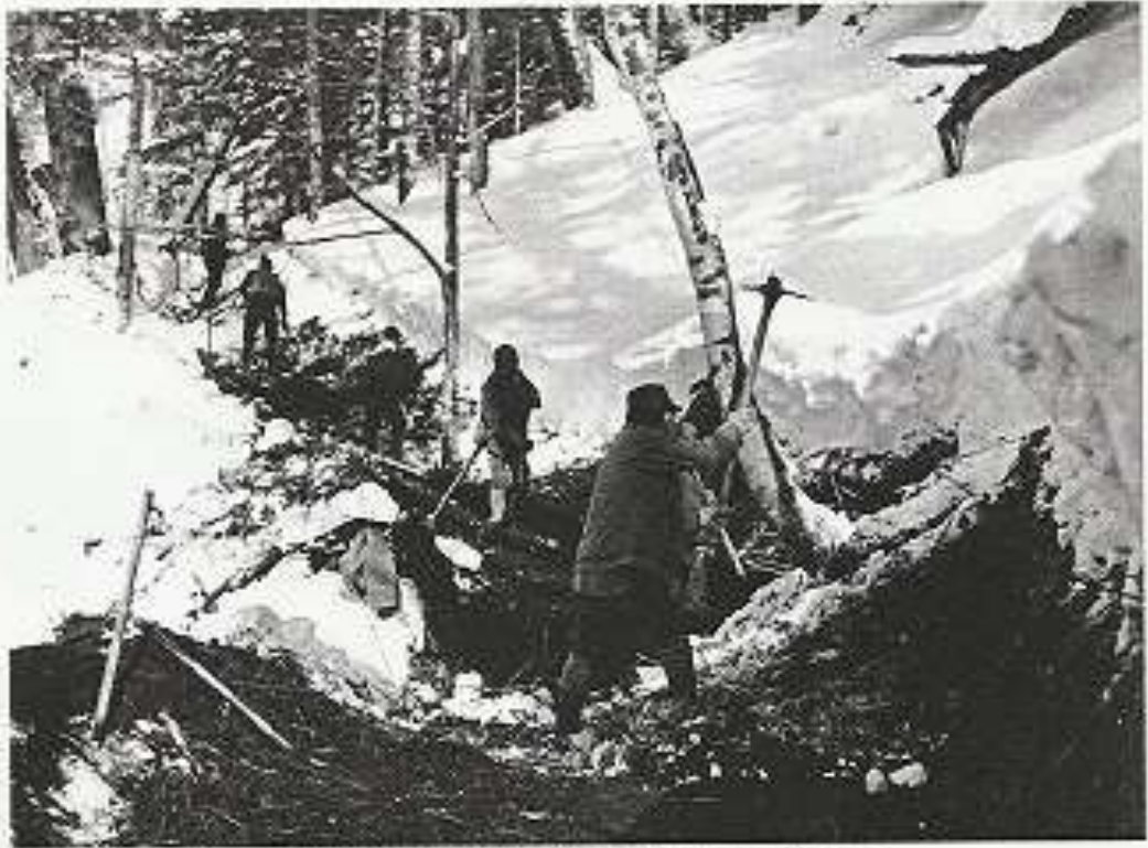
馬搬用の大道付作業、除雪片崩・切削・構築けと その地形に応じ作設していく
